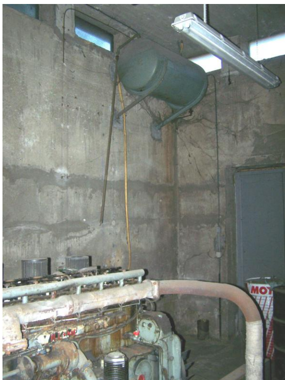
Salle du groupe électrogène avec cuve suspendue de fioul
