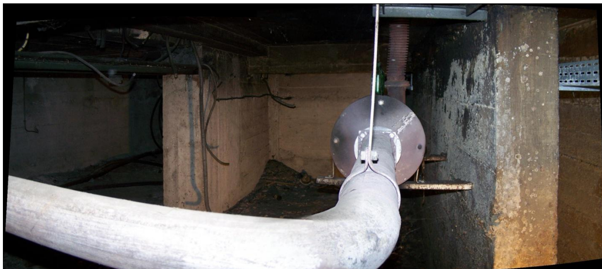
Panorama P7 du sous-sol du local transformateur, côté Ouest (le tuyau correspond à l'échappement des gaz brûlés du groupe électrogène au niveau N0)
